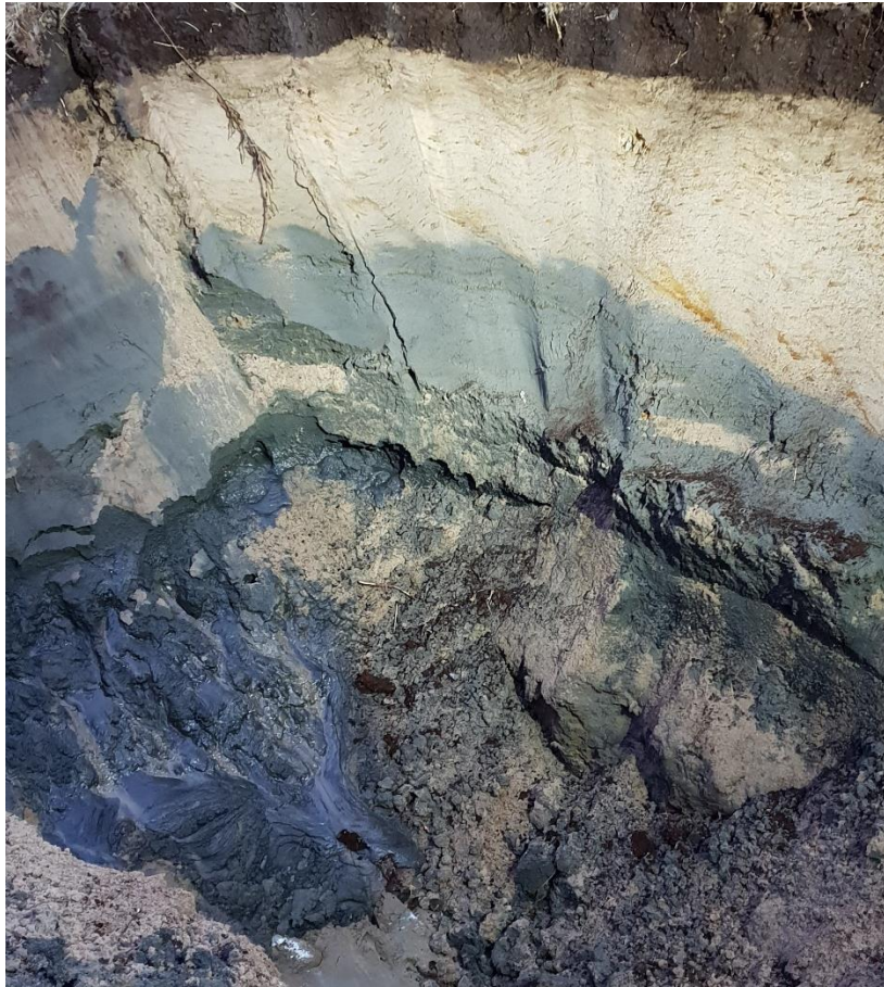
Kuva 5-1. Pisteessä KK2 havaittu rikkipitoinen maakerros näkyy kuvassa harmaalla. Kaivantoon purkautuu pohjavettä noin 1,2 m syvyydellä maanpinnasta.
